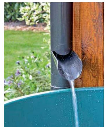
Die Dachrinnensysteme aus PVC werden einfach ineinander gesteckt. Der Heimwerker hat die Montage somit schnell erledigt – ganz ohne Löten wie bei den Varianten aus Metall.
