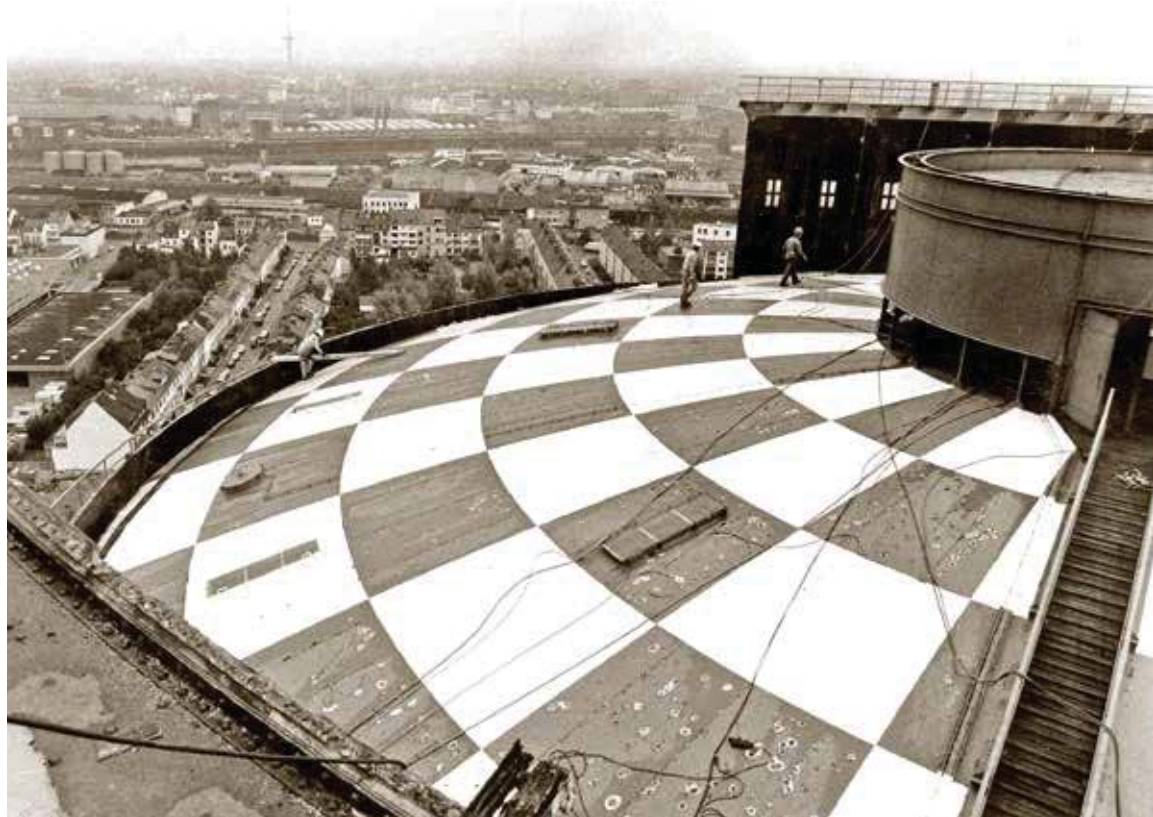
Nur drei Wochen dauerte der Abbruch des Gasometers – das Foto ist zu Beginn der Arbeiten im November 1984 entstanden. FOTO: JOCHEN STOSS / STAATSARCHIV BREMEN
